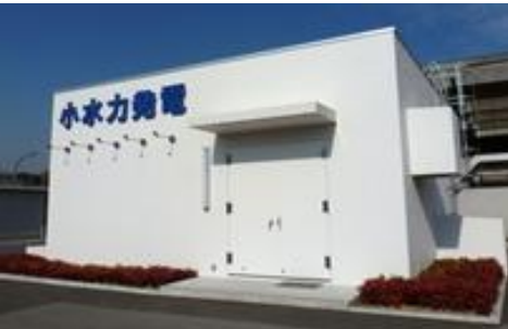
山崎浄水場 FIT小水力発電 (生駒市保有)
