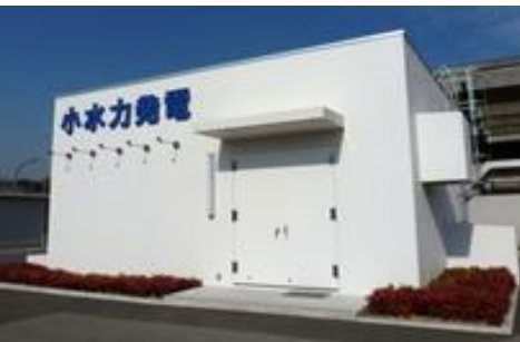
山崎浄水場 FIT小水力発電 (生駒市保有)
